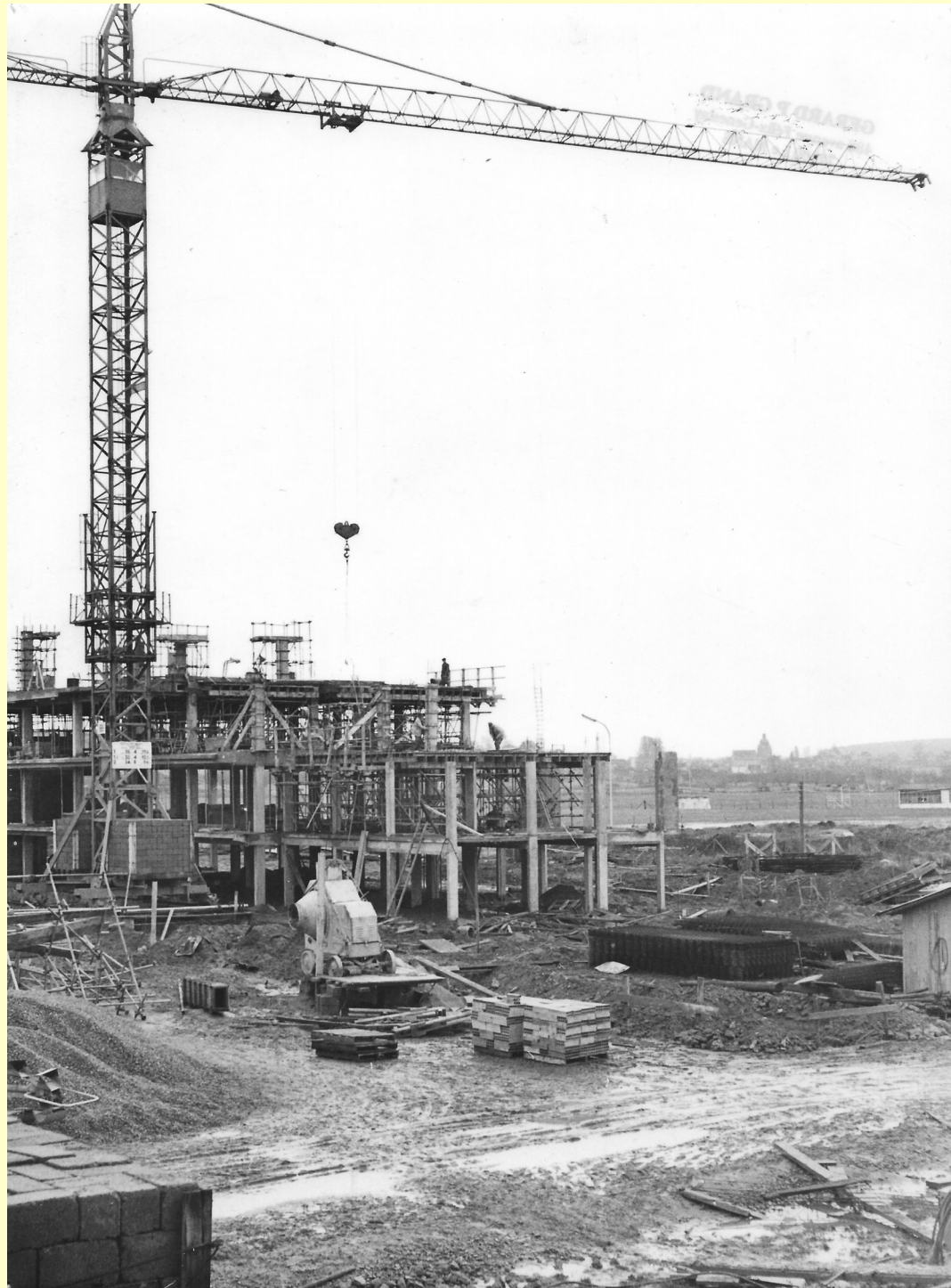
Le bâtiment D en construction
